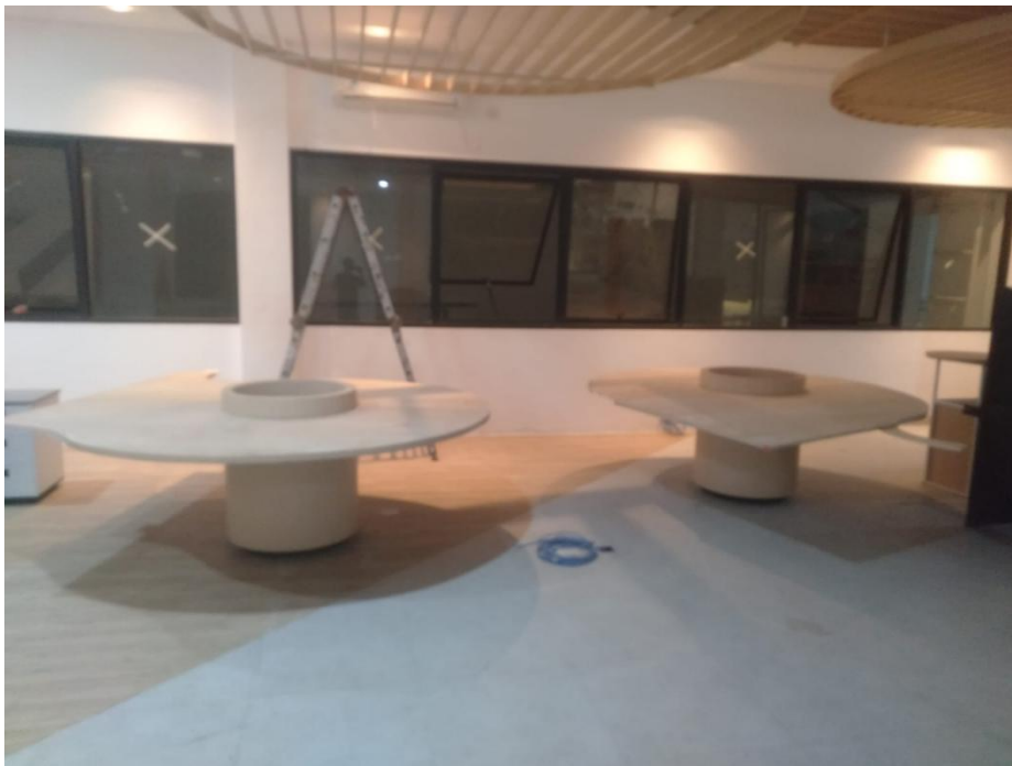
Gambar 8. Pemasangan Interior dan Furnitur
