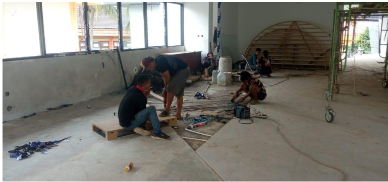
Gambar 6. Persiapan Pemasangan Interior
